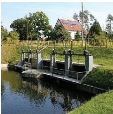
Ryc. 5. Dawna strażnica kanału w miejscowości Zapora. Na pierwszym planie jaz wlotowy na Wielki Kanał Brdy (fot. R. Borzyszkowski)
