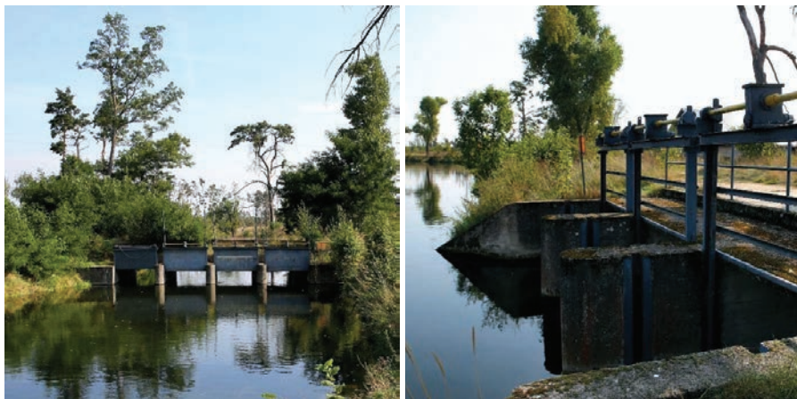
Ryc. 9. Miejscowość Konigort, jaz zamykający kanał (lewo), jaz boczny stanowiący wlot na kanał zrzutowy (prawo) (fot. R. Borzyszkowski)
