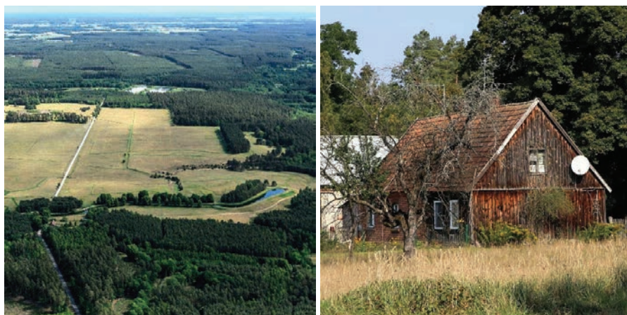
Ryc. 17. Kompleks łąk Zielona Łąka (lewo, fot. B.Z. Chojeła), dawna strażnica kanału w miejscowości Zielona Łąka (prawo, fot. R. Borzyszkowski)
