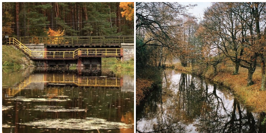
Ryc. 13. Podsystem MKB – jaz wlotowy na Mały Kanał Brdy (lewo), widok na Mały Kanał Brdy (prawo) (fot. R. Borzyszkowski)
