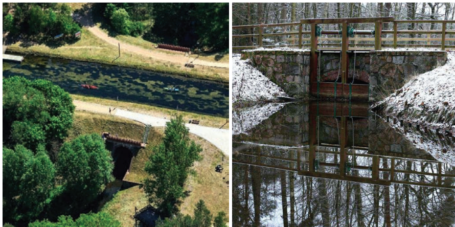
Ryc. 12. Podsystem WKB odcinek Konigort – Barłogi: akwedukt w Fojutowie (lewo, fot. B.Z. Chojęta), jaz na doprowadzalniku Czubyryń (prawo, fot. R. Borzyszkowski)
